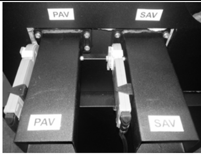
Obr. č. 6 Montáž přírub a pohonů klapek
