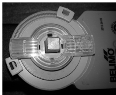
Obr. č. 20 Poloha klápek a servopohonu SAV a PAV zavřeno (počáteční stav - otevření 0%)
